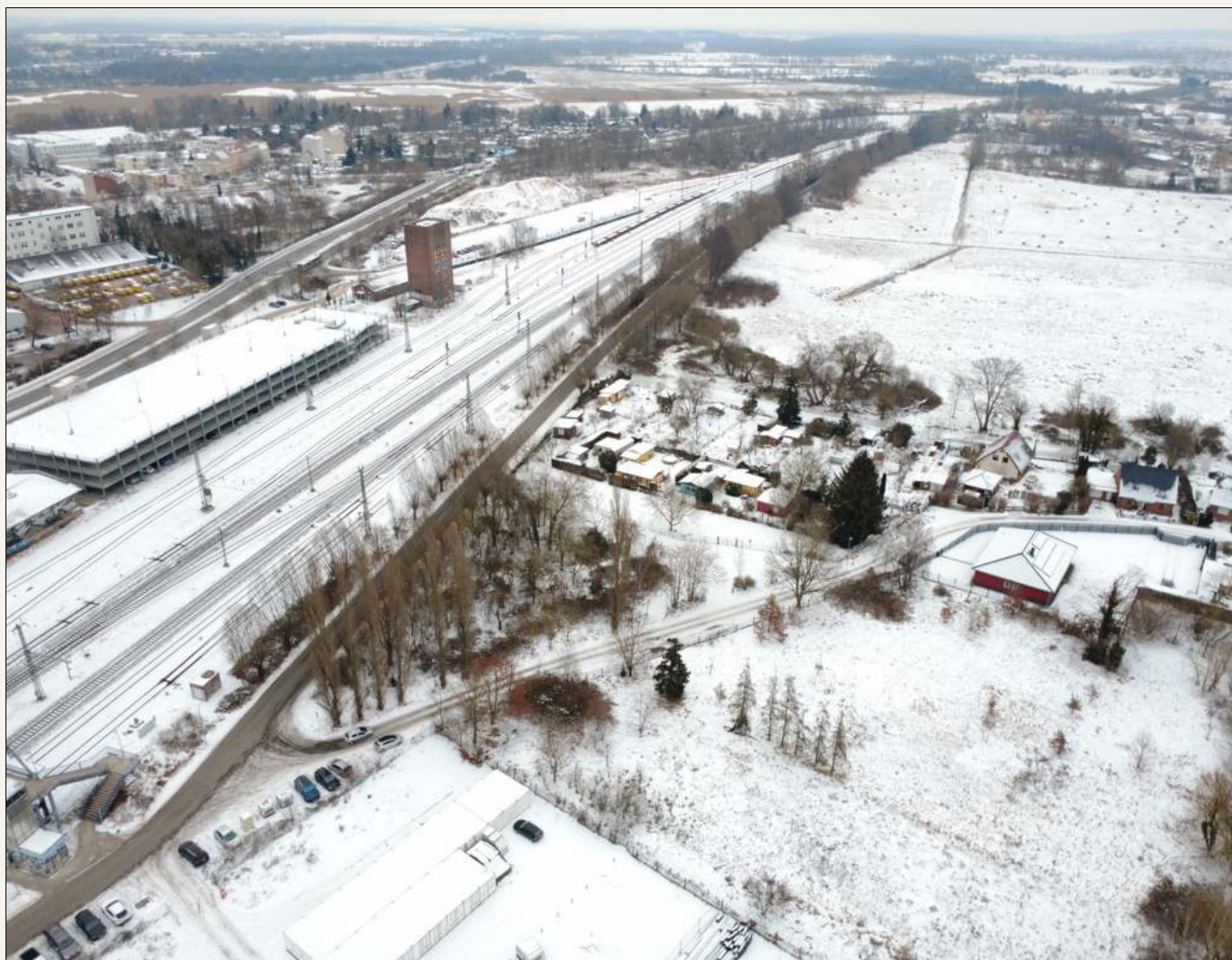
Abb.: Potsdamer Landstraße, 14776 Brandenburg an der Havel
