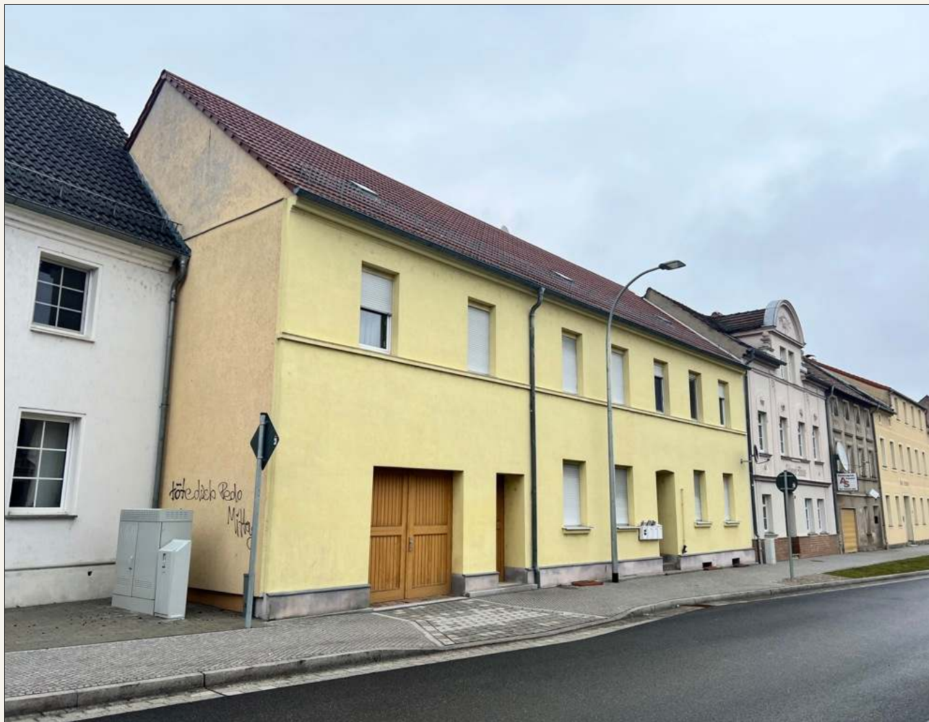
Abb.: Jüterboger Straße 21, 15936 Dahme/Mark
