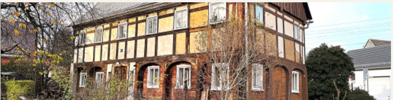
Abb.: Schenaustraße 16, 02779 Großschönau
