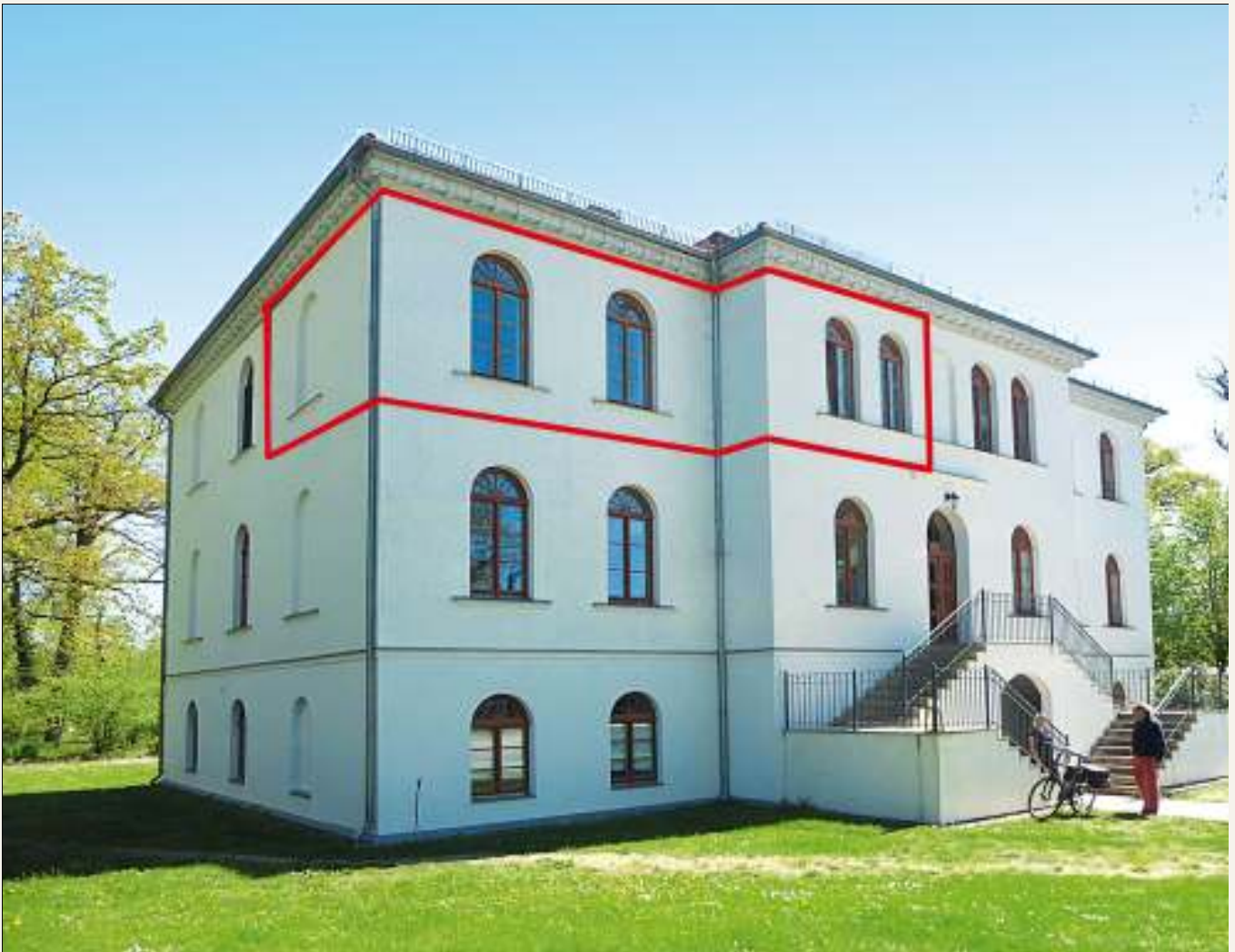
Abb.: Gartenstraße 4, 39624 Kalbe (Milde)
