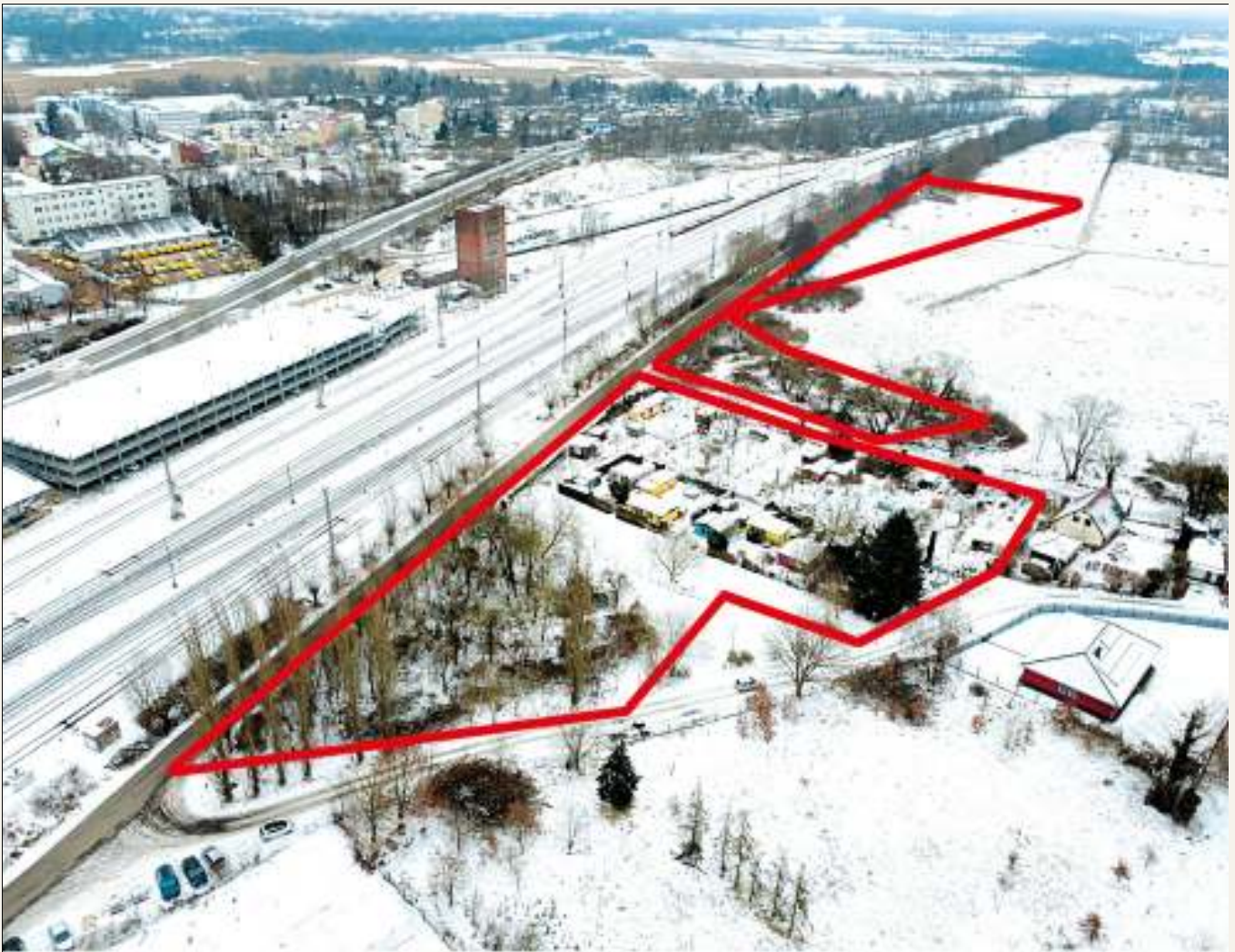
Abb.: Potsdamer Landstraße, 14776 Brandenburg an der Havel
