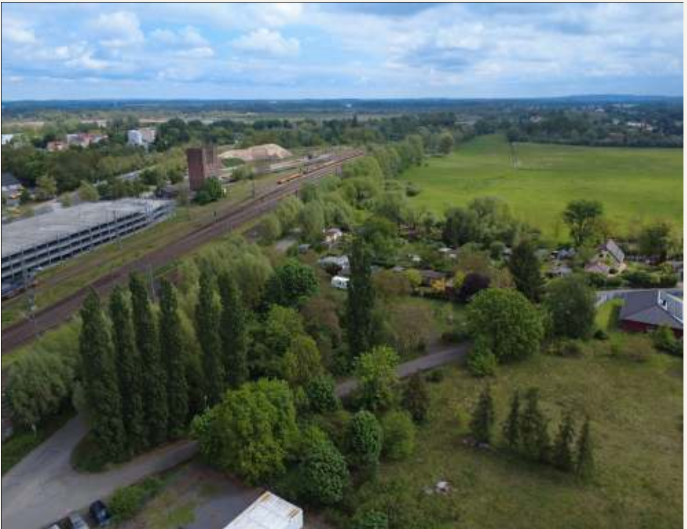
Abb.: Potsdamer Landstraße, 14776 Brandenburg an der Havel
