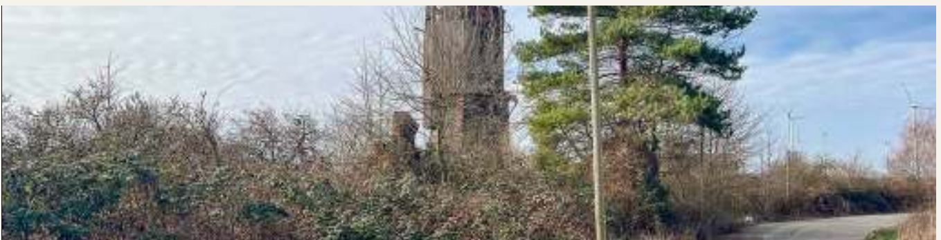
Abb.: Hinter dem Bahnhof 23, 06682 Teuchern
