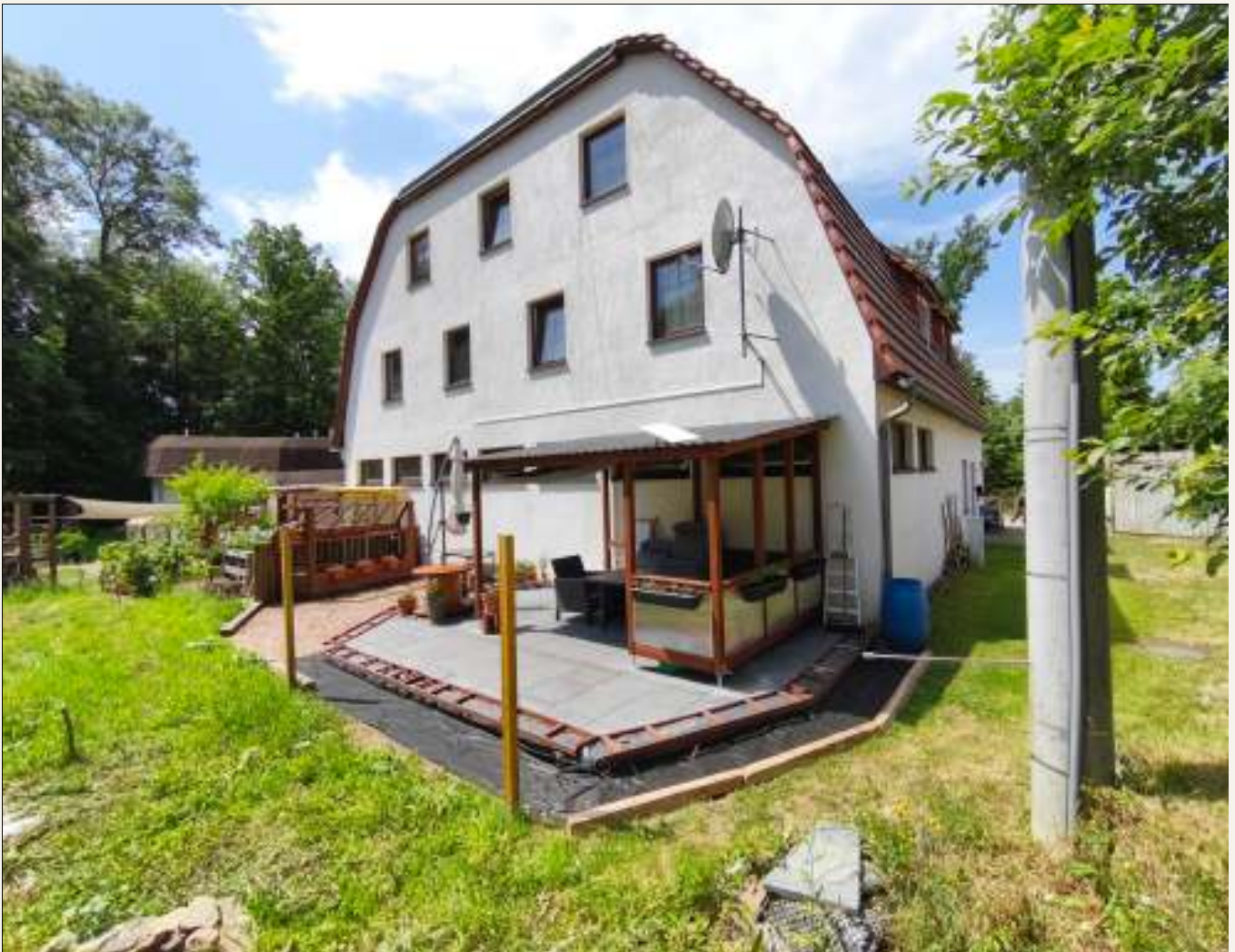
Abb.: Talstraße 54, 09628 Reinsberg
